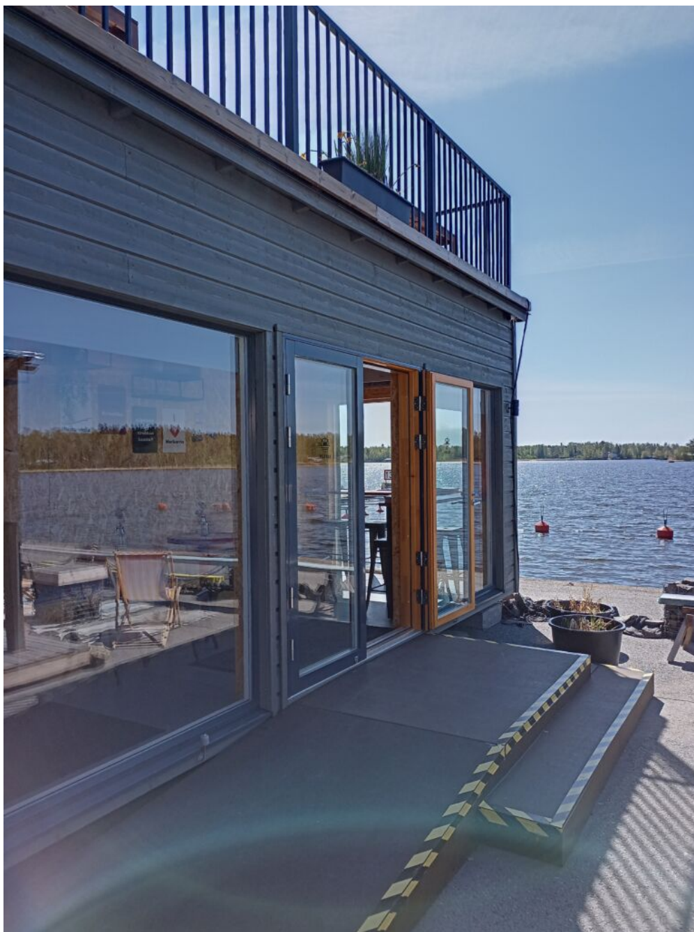
Kuva 4. Vanhat merikontit ovat saaneet uuden elämän Plassin rakennuksessa.
