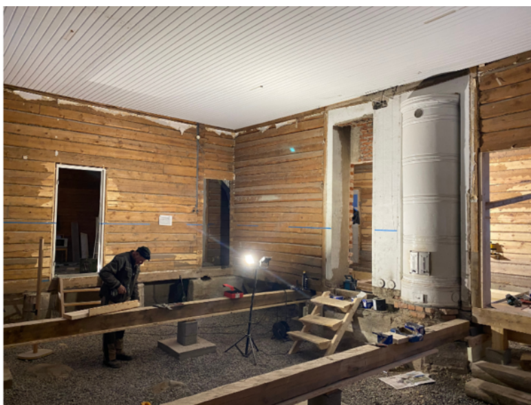
Kuva 4. Rakennuksen alapohjan korvaaminen rossipohjalla (kuva: Helena Yli-Harja, 2024).
