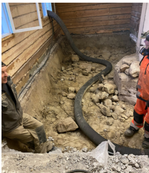
Kuva 4. Rakennuksen alapohjan korvaaminen rossipohjalla (kuva: Helena Yli-Harja, 2024).
