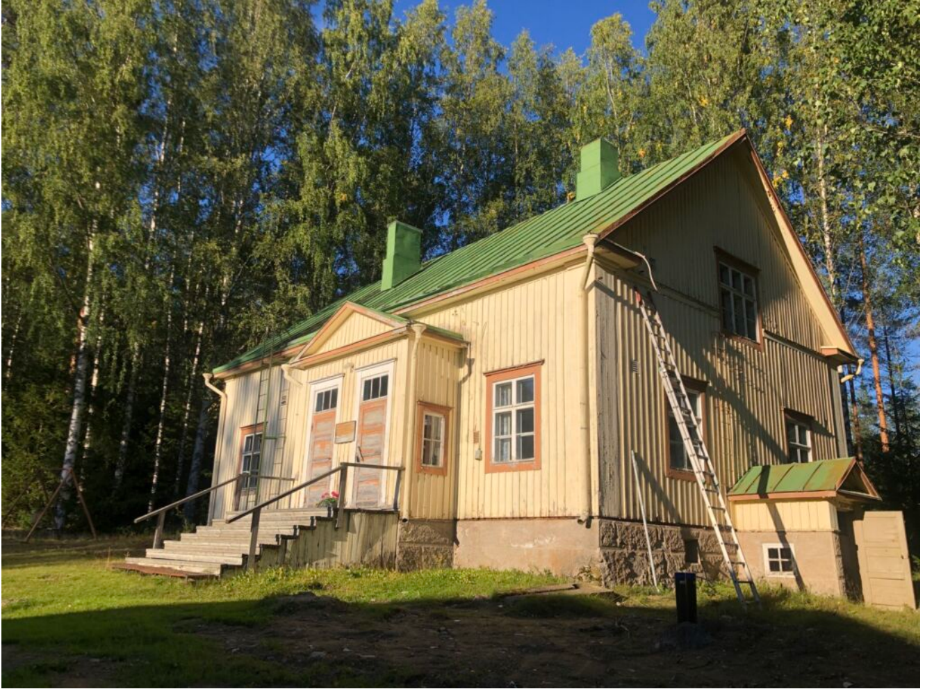
Kuva 1. Rakennus ulkoa (kuva: Helena Yli-Harja, 2024).
