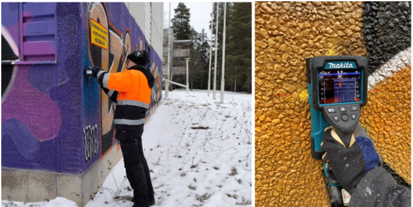
Kuvat 3 ja 4. Betonipeitteen paksuuden mittaaminen ja terästen paikannus käynnissä (kuva: Sami Perälä ja Matti Ylihärtilä, 2025).
