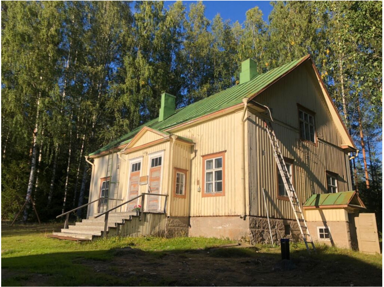
Rakennus ulkoa (kuva: Helena Yli-Harja).
