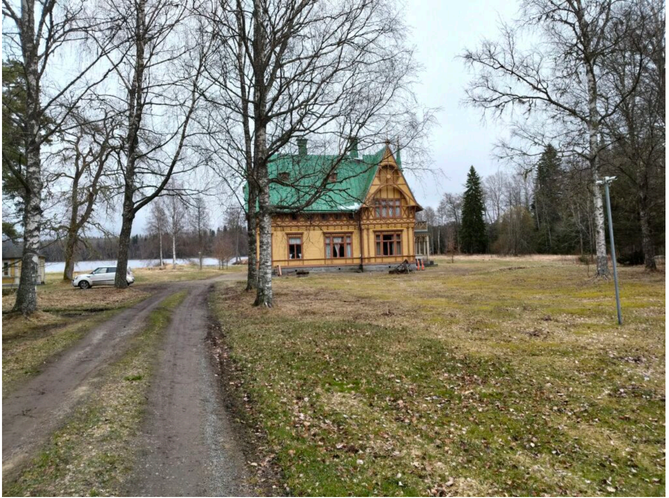
1896 rakennettu Carlsron huvila (kuva: Sami Perälä).
