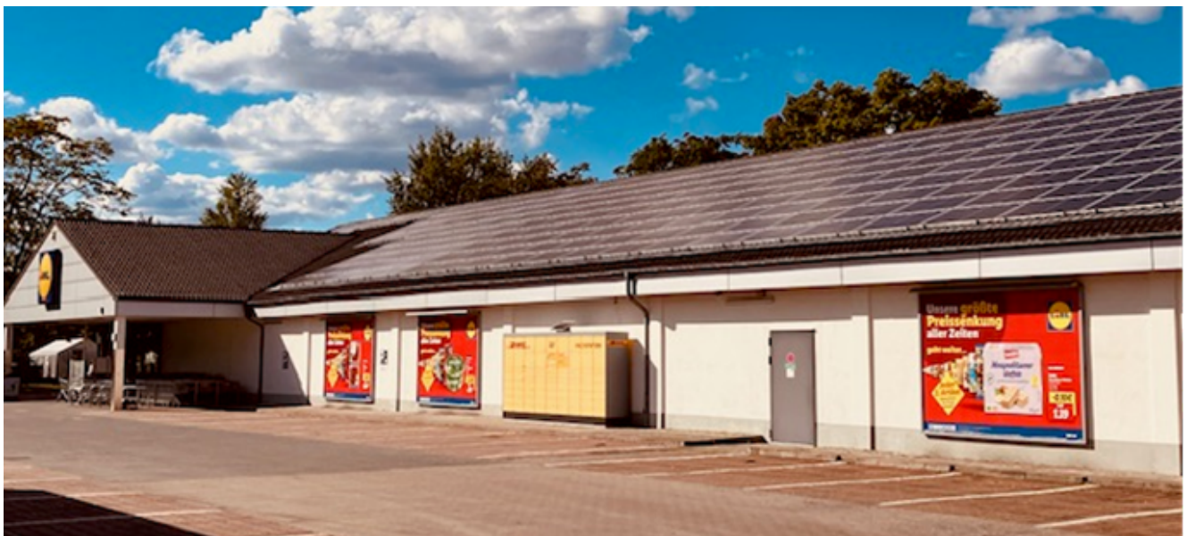
Kuva 19. Aurinkopaneelit Lidl kauppakiinteistössä (kuvat: Olli Isopahkala, 2025).
