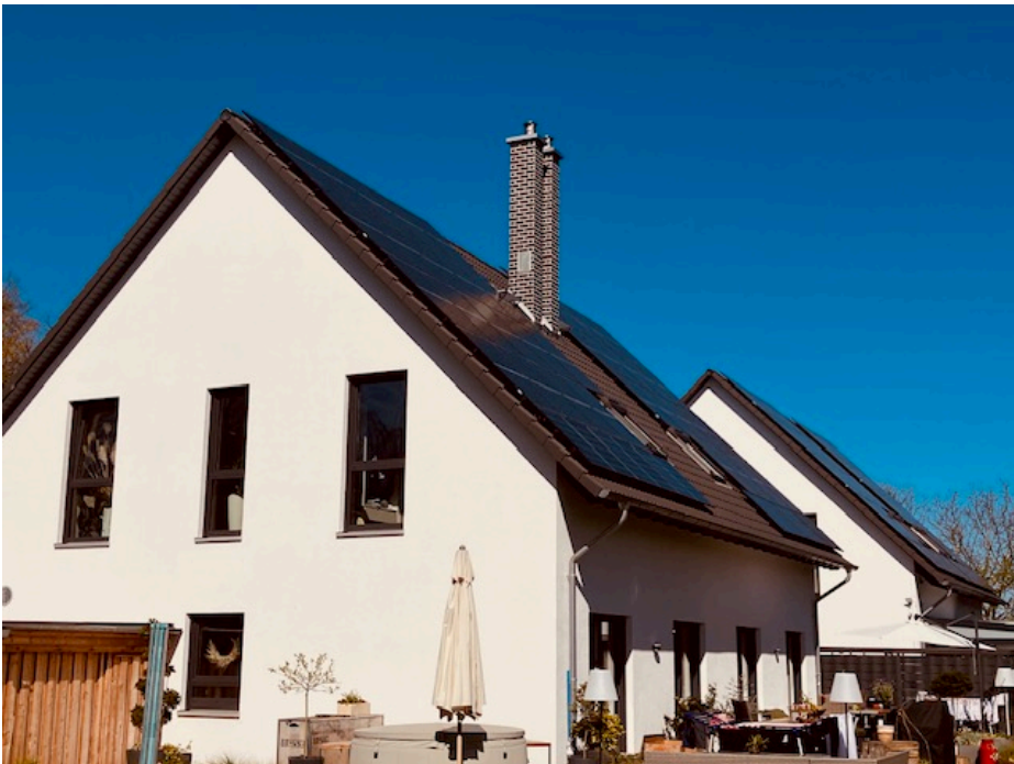
Kuvat 17 ja 18. Luonnonmukaiset eristeet ja asuinrakennuksen aurinkopaneelit (kuvat: Olli Isopahkala, 2026).
