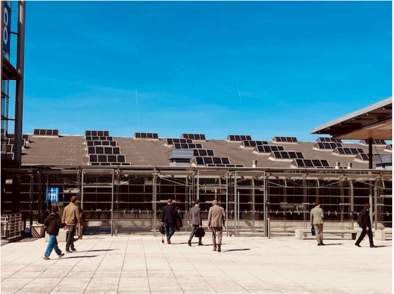
Kuva 10. Aurinkopaneelit rakennuksen katolla (kuva: Olli Isopahkala, 2026).
