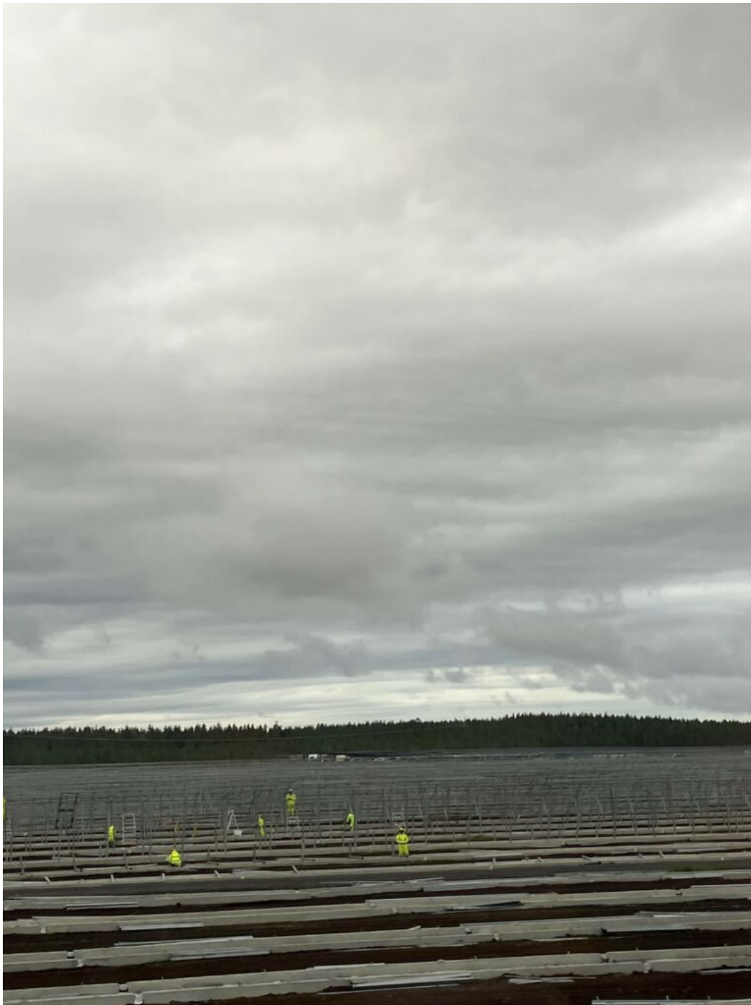
Näkymää Lapuan Heininevan aurinkovoimalatyömaalta (kuva: Risto Lauhanen 2024).
