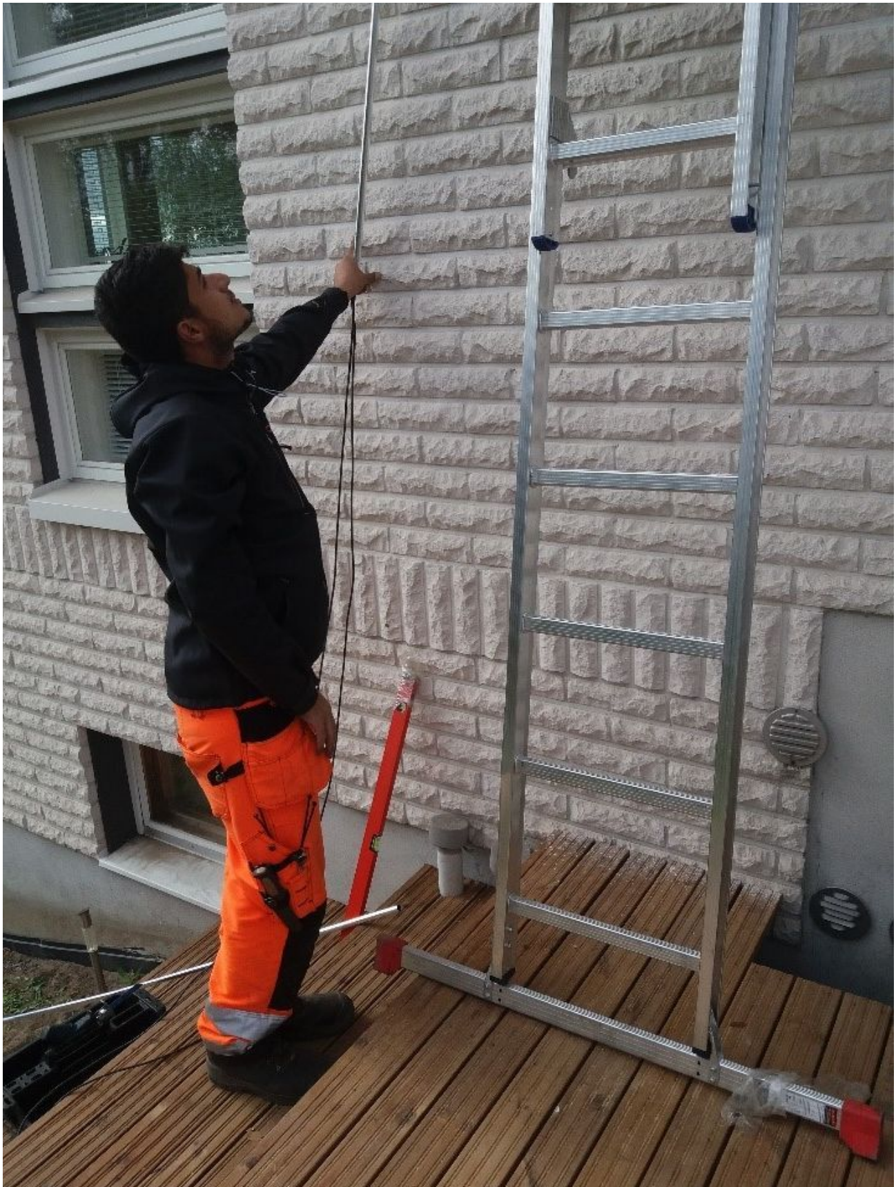
Kuva 9. Katolta tulevat kaapelit asennettiin alumiiniseen suojaputkeen pinta-asennuksena.
