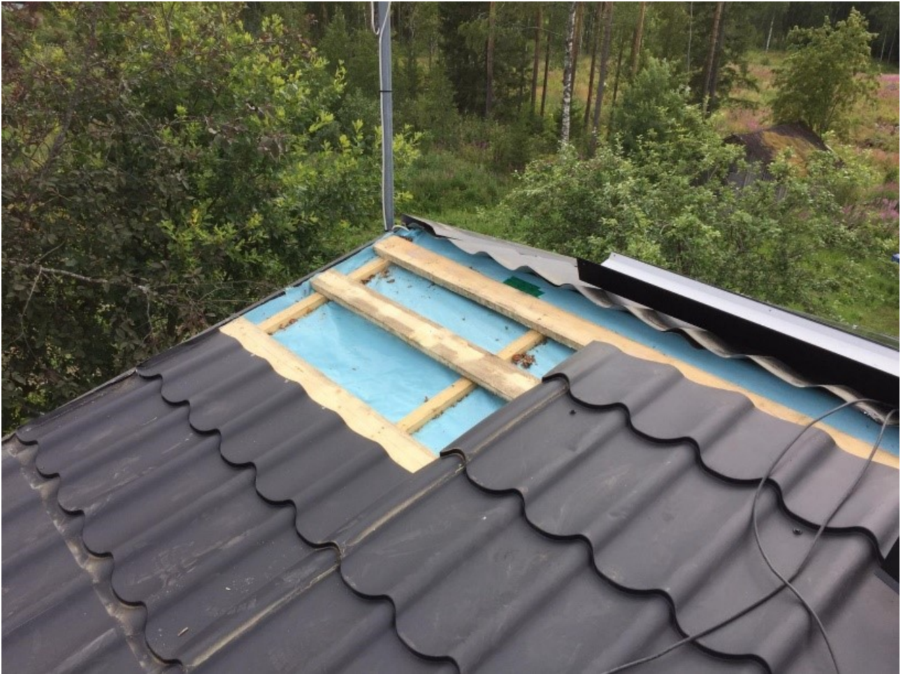
Kuva 8. Paneeleista tulevat sähköjohdot vedettiin harja- ja kattopeltien alta tiiliseinään talon eteläpäätyyn.
