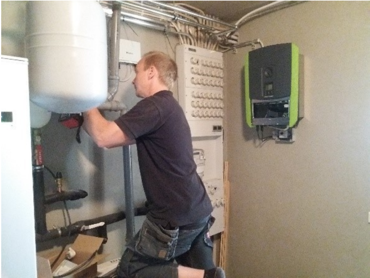
Kuva 1. Sähkömies asensi sähköpääkeskukseen energianseurantajärjestelmän ja vihreän Kostal-merkkisen invertterin (oikealla). Omakotitalon lämmitysmuoto on maalämpöpumppu (Nibe), josta osa näkyy vasemmalla.
