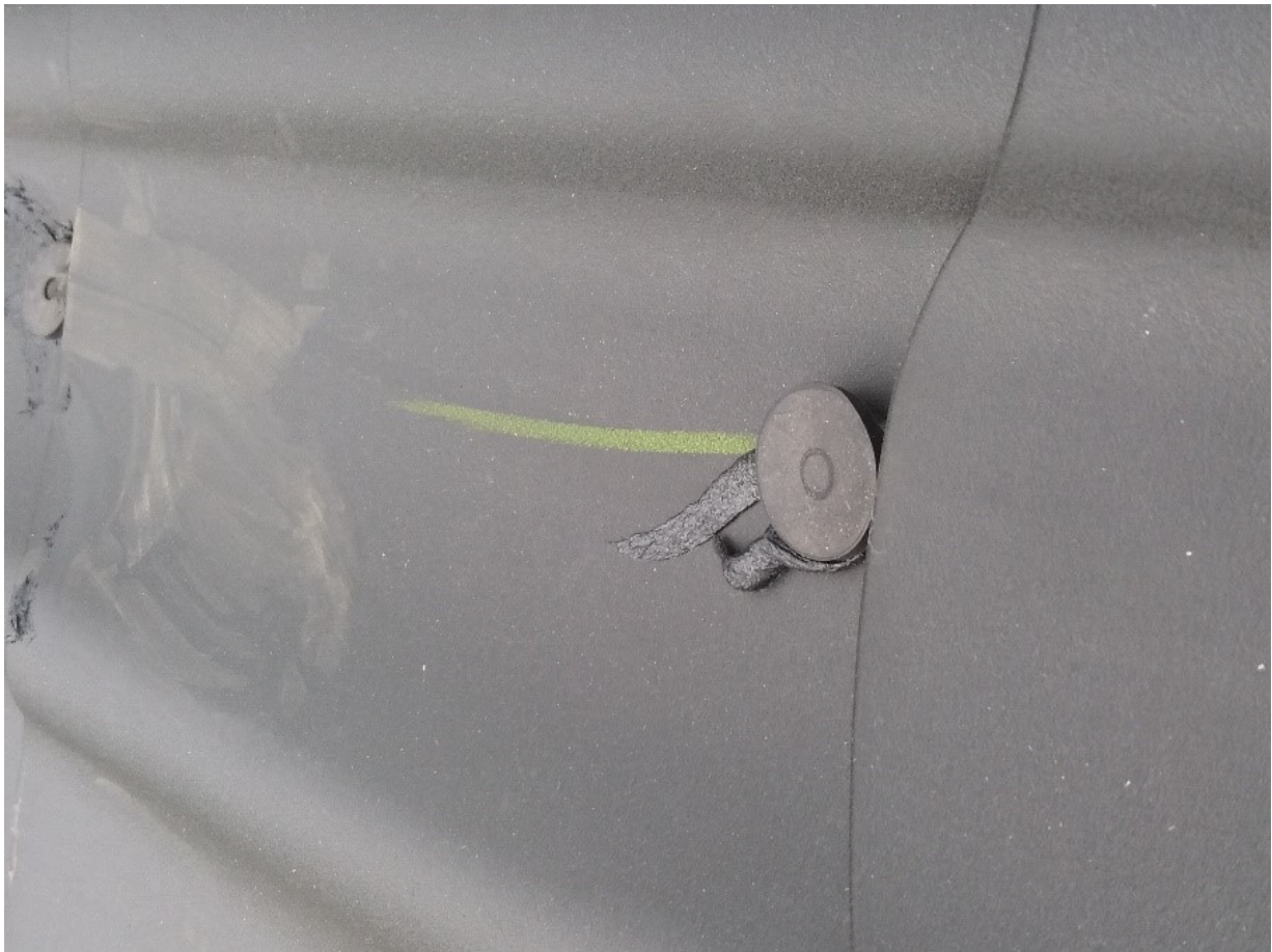
Kuvat 4-5. Paneelien paikat merkitään kattoon liidulla ja kiinnikkeet asennetaan katolle. Kiinnikkeiden päälle tuli metallikiskot. Peltikattoon kiinni tuleva ruuvi tiivistetään bitumilla. Kumipidikkeet vähentävät metallien
