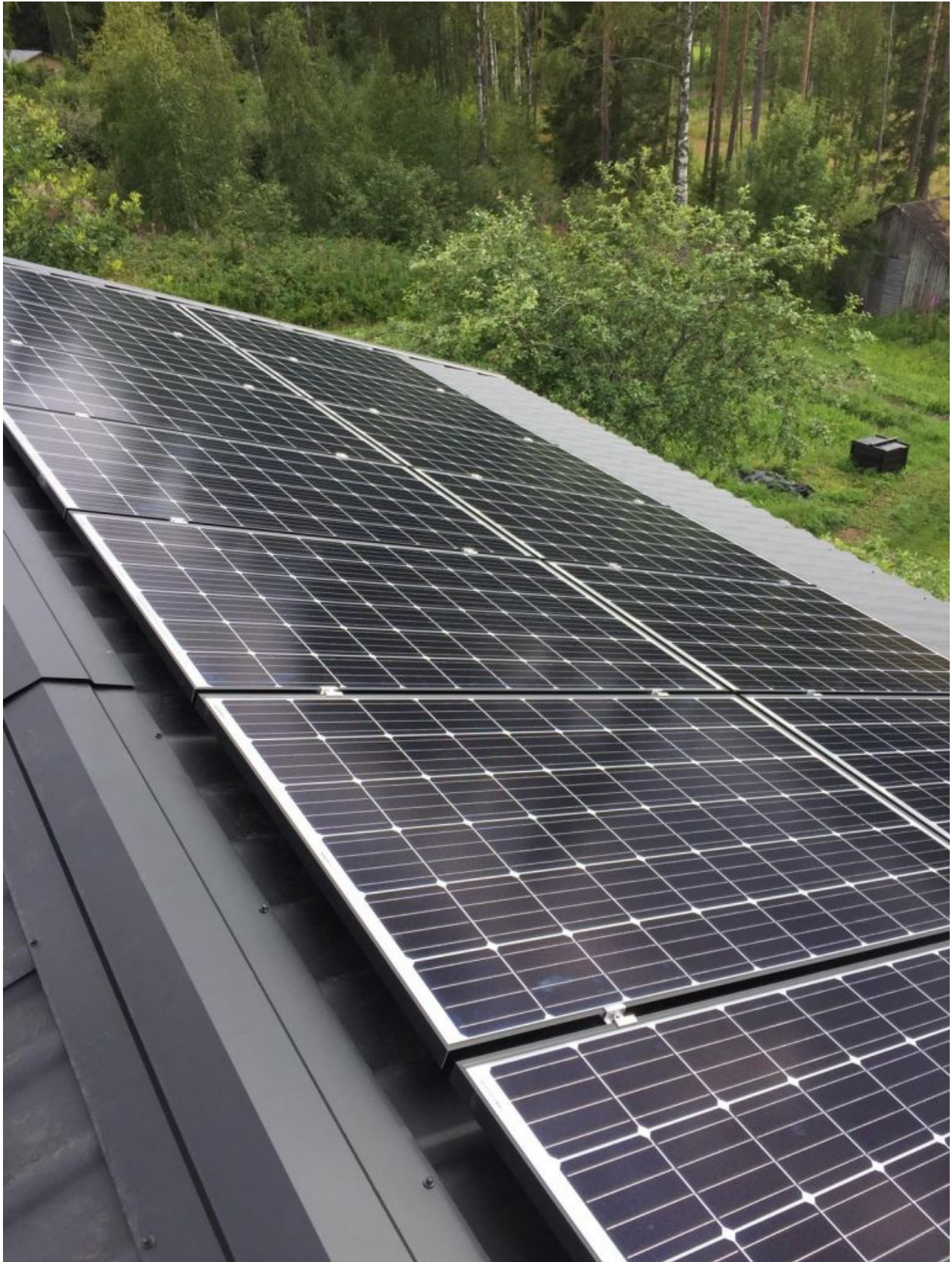
Kuva 7. Paneelit asennettiin lounaanpuoleiselle lappeelle kahteen riviin.
