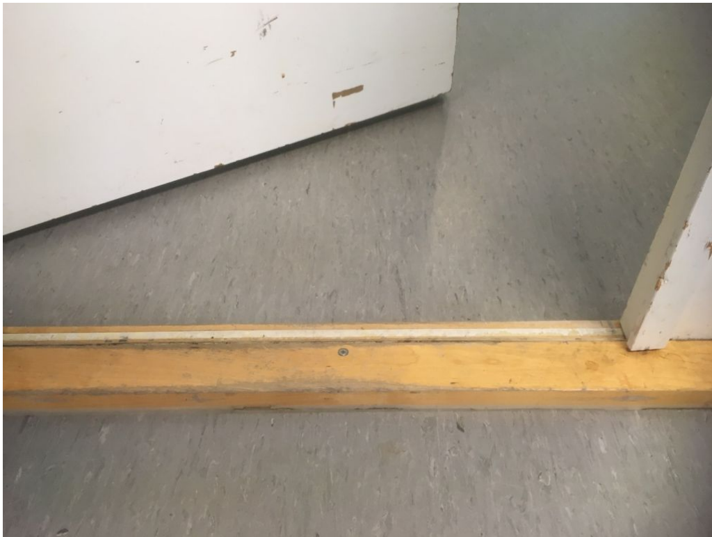
Kuva 11. Kynnykset vaikeuttavat liikkumista Frami A:ssa.
