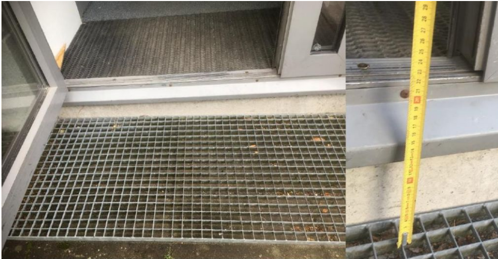
Kuva 6. Sisäänkäynti Frami C:hen.
