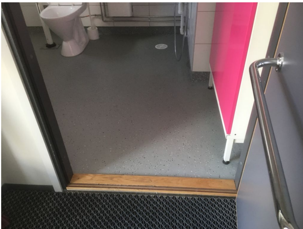
Kuva 12. Frami H:n lähes ainoa kynnys löytyy inva-WC:stä, mutta sen korkeus on sallittu 20 mm.
