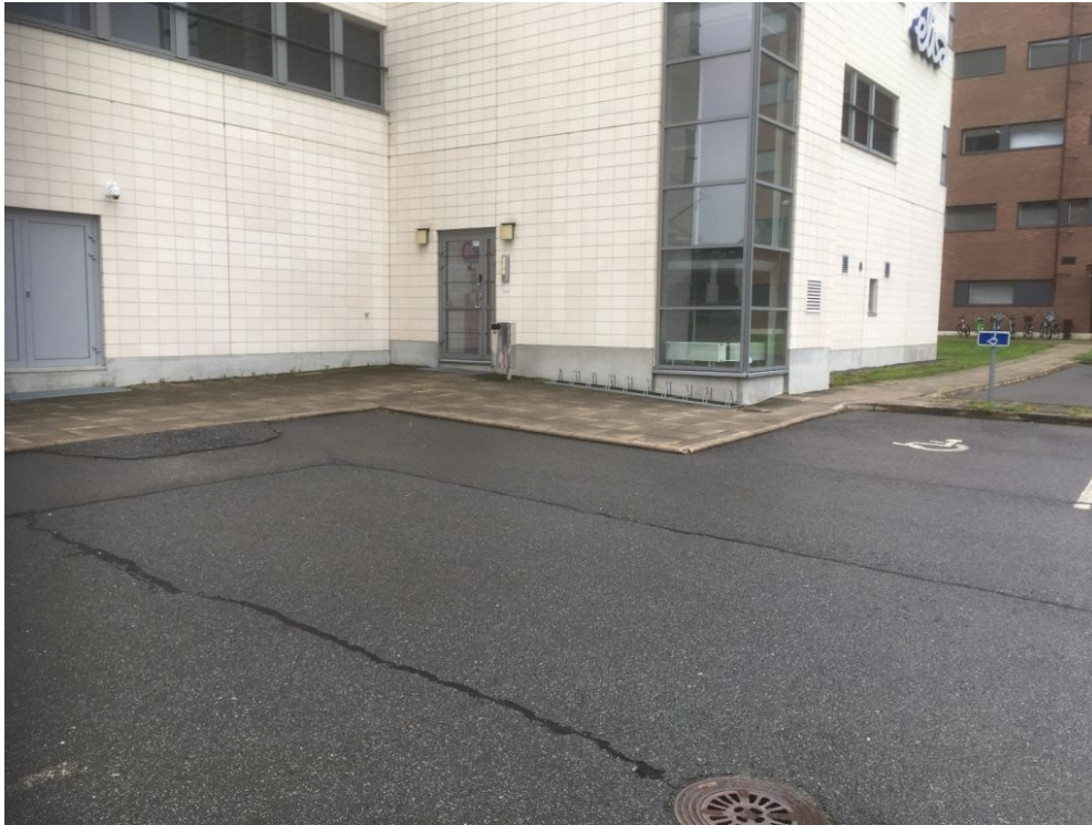
Kuva 2. Esteetön pysäköintipaikka Frami C:n päädyssä.
