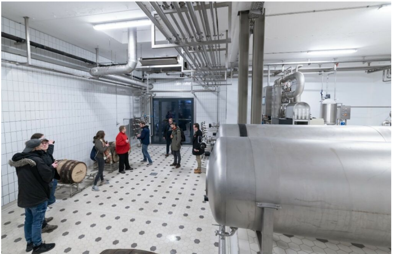
Kuva 5. Moderni oluen valmistusteknologia oli sijoitettu yksityiskohtia myöden siististi osaksi perinteistä rakennusta. Linnapanimon kellarissa sijaitsivat käymissäiliöt (Kuva: Arthur Isaak).
