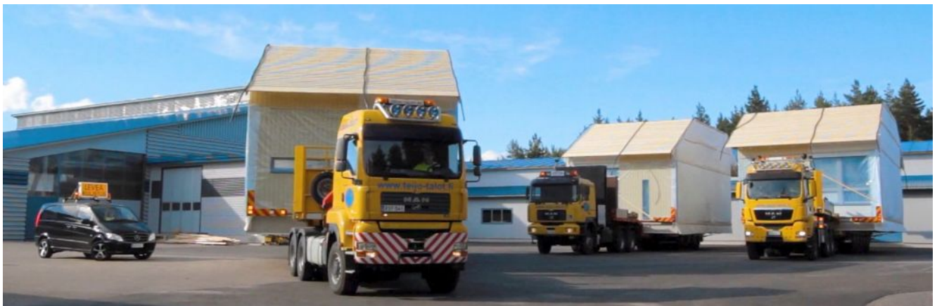
Kuva 1. Teijo-talojen tilaelementit siirretään perustuksineen. Kuva Teijo-Talot Oy.
