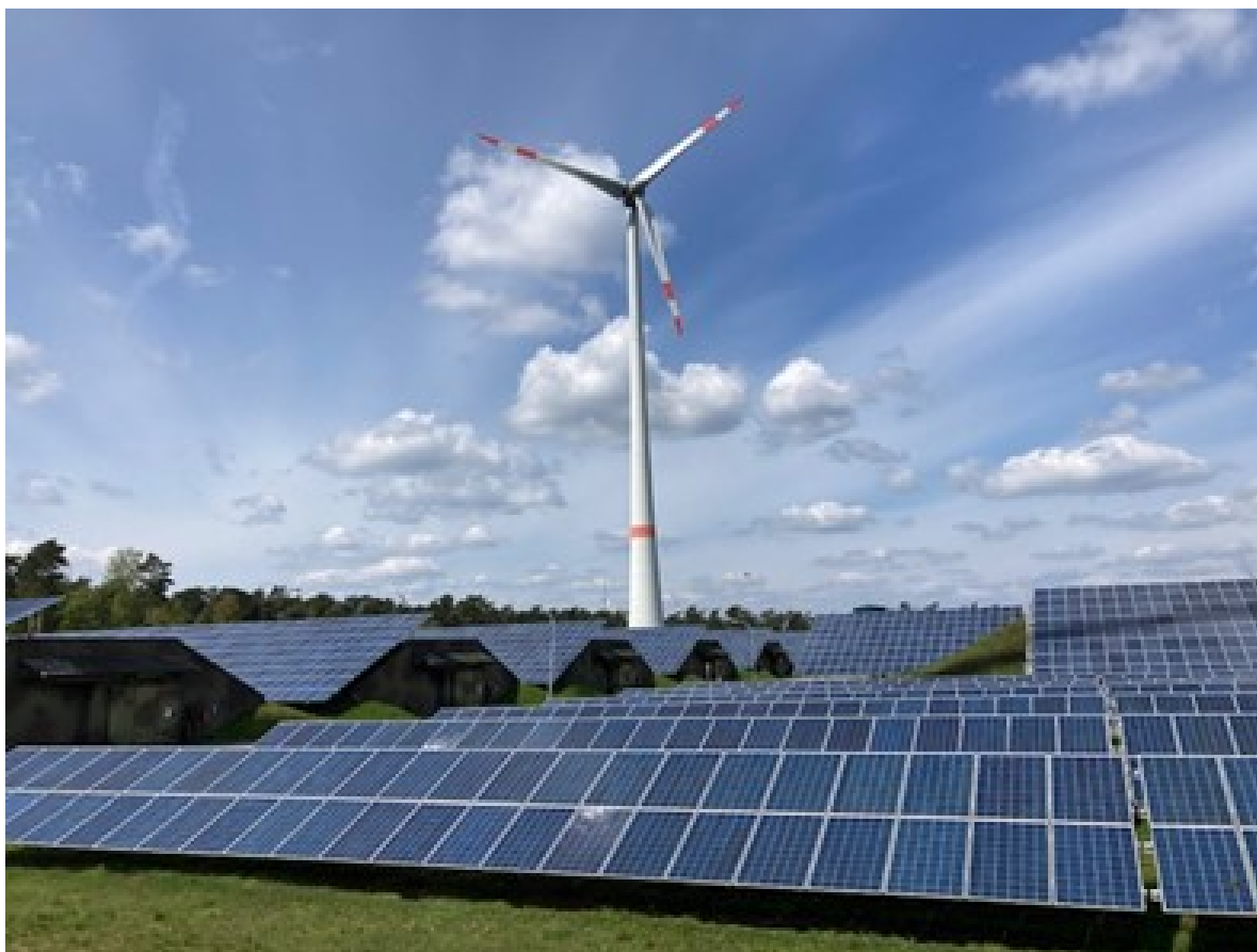
Kuva 1. Saerbeckin ekokylän bioenergiapuisto (Kuva: Marita Viljanmaa).
