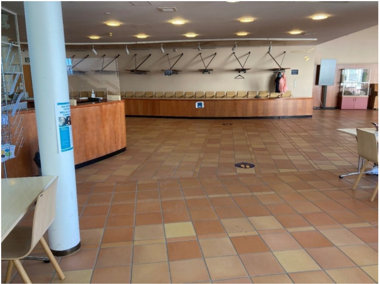
Kuva 11. Opastus ravintolan WC-tiloihin
